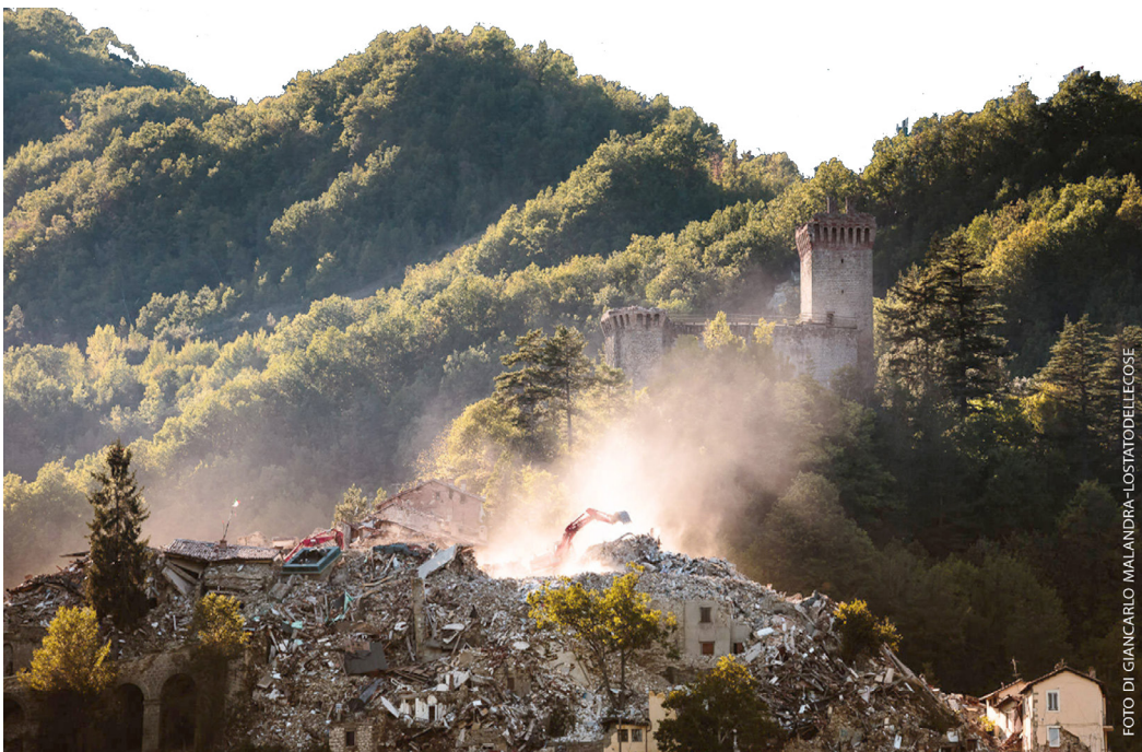
Arquata del Tronto durante le demolizioni post-sisma, 2017. (Foto di Giancarlo Malandra da http://www.lostatodellecose.com/ ).
